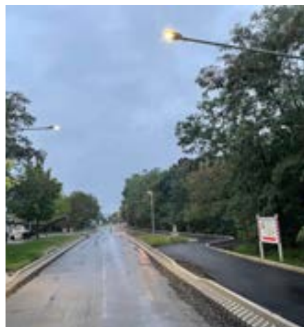
V části ulice už funguje nové osvětlení
