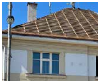
STŘECHA BĚHEM OPRAVY
