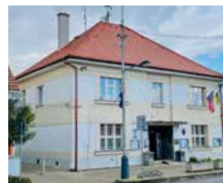
NOVÁ STŘECHA MĚÚ
