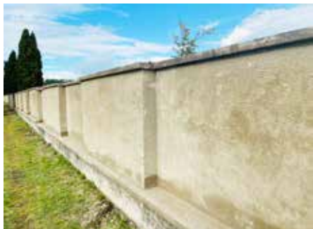
ZÁPADNÍ ČÁST HŘBITOVNÍ ZDI
