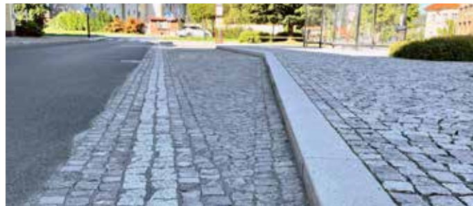
ZASTÁVKA PO OPRAVĚ
