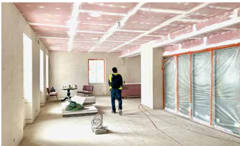
HOTOVÉ SÁDKOKARTONOVÉ STROPY A PROSKLENÁ STĚNA V BUDOUCÍ KNIHOVNĚ
