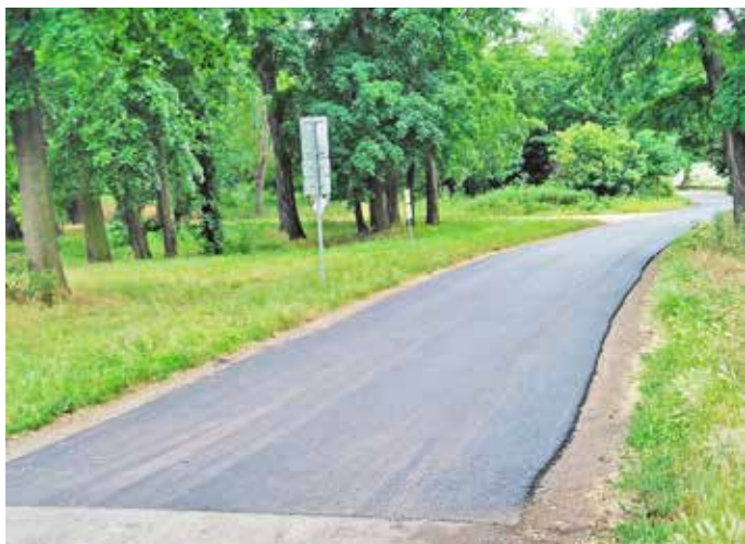
NOVĚ POLOŽENÝ ASFALT NA PŘÍJEZDOVÉ CESTĚ (FOTO: JAN BULÍN)
