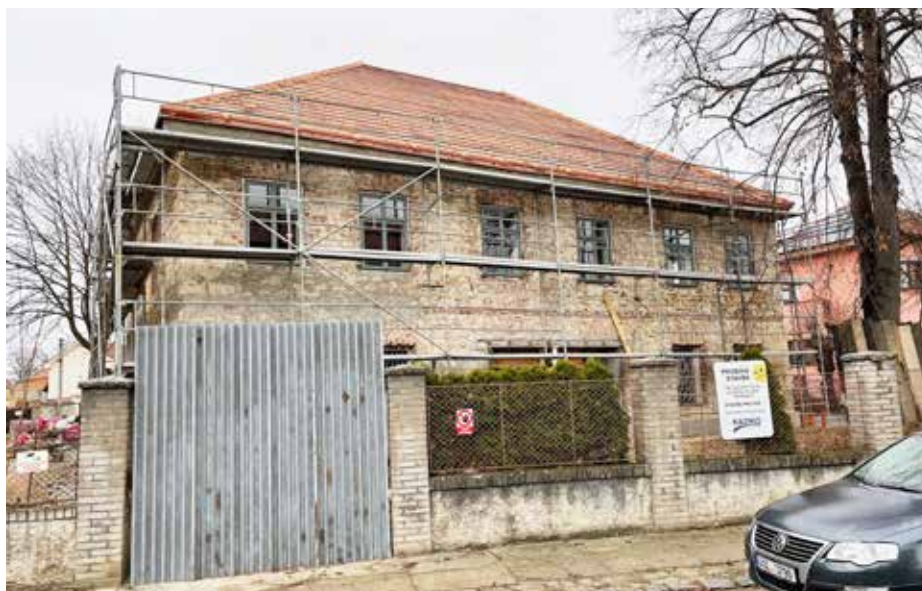
POHLED NA NOVÝ KROV A NOVĚ OSAZENÁ VNĚJŠÍ OKNA KOMUNITNÍHO CENTRA
