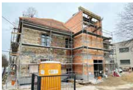
PRÁCE NA PŘÍSTAVKU PRO VÝTAH
