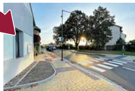
NOVÝ CHODNÍK A PŘECHOD PRO CHODCE V TŘEBÍZSKÉHO ULICI
