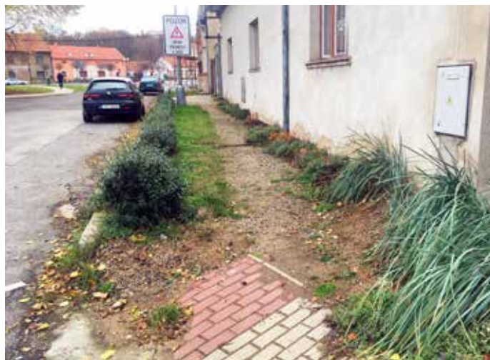
PŮVODNÍ STAV CHODNÍKU V ULICI TŘEBÍZSKÉHO, KTERÝ SE BUDOVAL V RÁMCÍ DODATEČNÝCH PRACÍ ZA ÚCELEM PROPOJENÍ OPRAVENÉ KŘIŽOVATKY ŽIŽKOVA/JUNGMANNOVA S NOVĚ BUDOVANÝM CHODNÍKEM V TŘEBÍZSKÉHO
