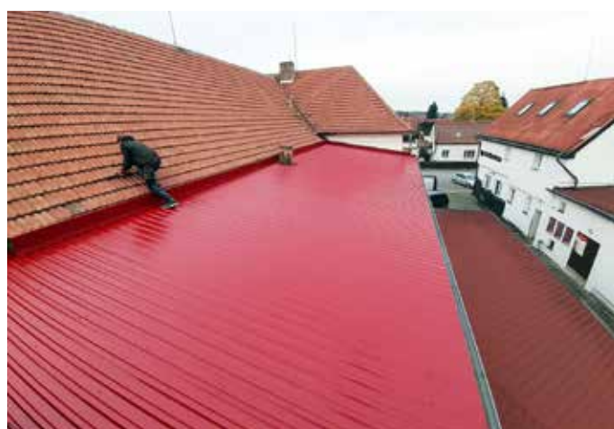
NOVÁ STŘECHA NA MALÉ TĚLOCVIČNĚ SOKOLOVNY
