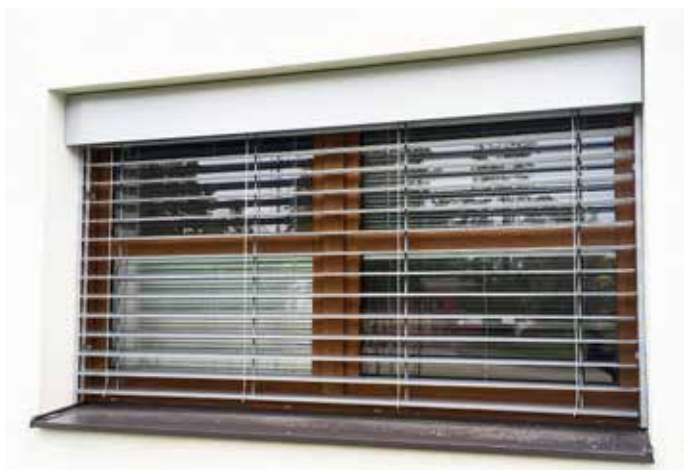
NOVÉ ŽALUZIE NA OKNECH ZÁKLADNÍ ŠKOLY
