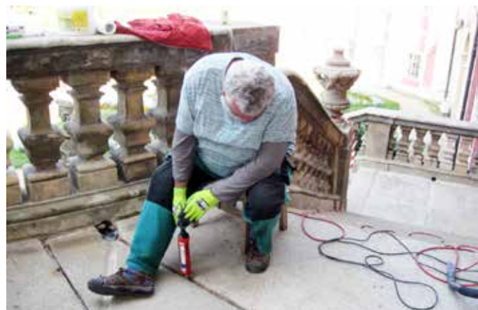
TĚSNĚNÍ SPAR SPECIÁLNÍM TMELEM
