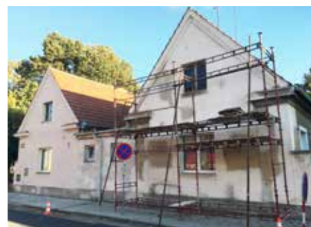
OPRAVUJE SE FASÁDA DVOJDOMKU S DRUŽINOU.
