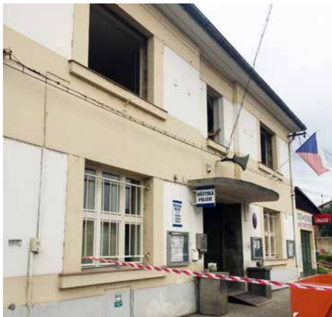
VÝMĚNA OKEN NA BUDOVĚ MĚSTSKÉHO ÚŘADU
