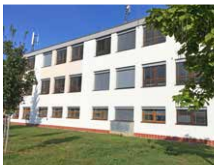
... POŘÍDIT ŽALUZIE NA JIŽNÍ STRANU ZÁKLADNÍ ŠKOLY.
