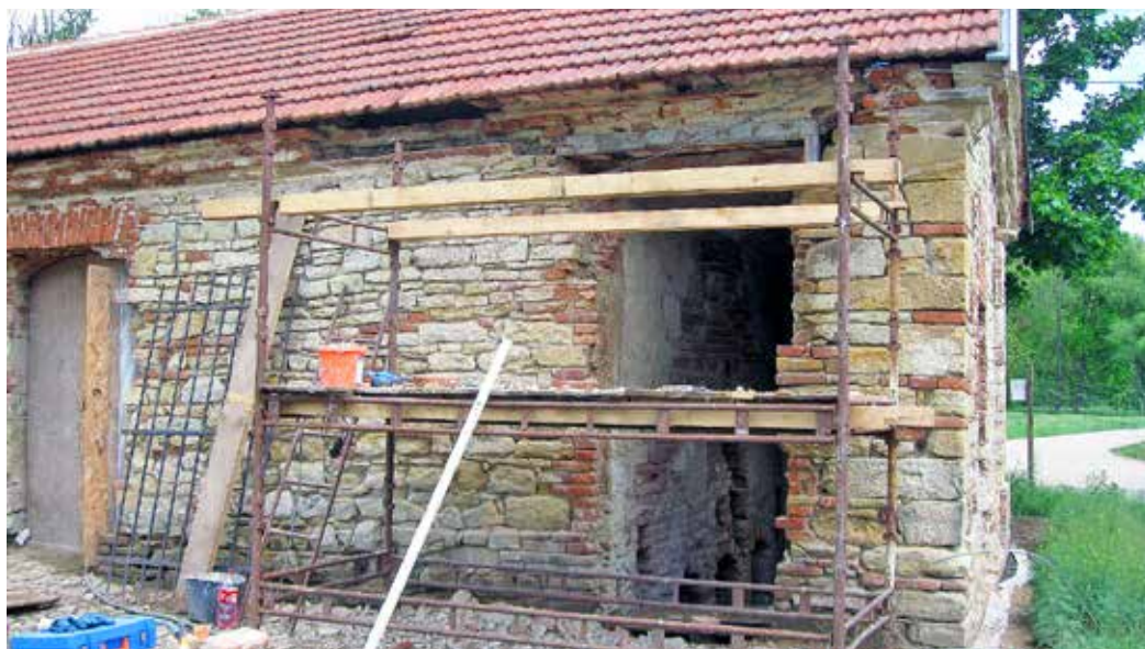
SUŠÁRNA S VYBOURANÝM PŘÍSTUPEM K TOPENIŠTÍM
