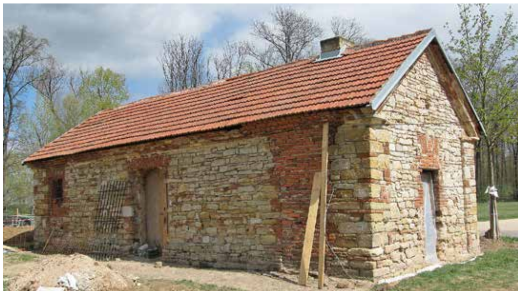
SUŠÁRNA JEŠTĚ S NEVYBOURANÝM PŘÍSTUPEM K TOPENIŠTÍM
