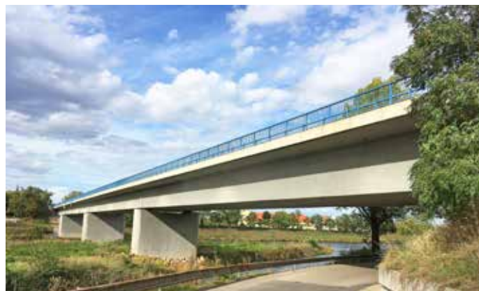
2019 – Nový most po opravě
