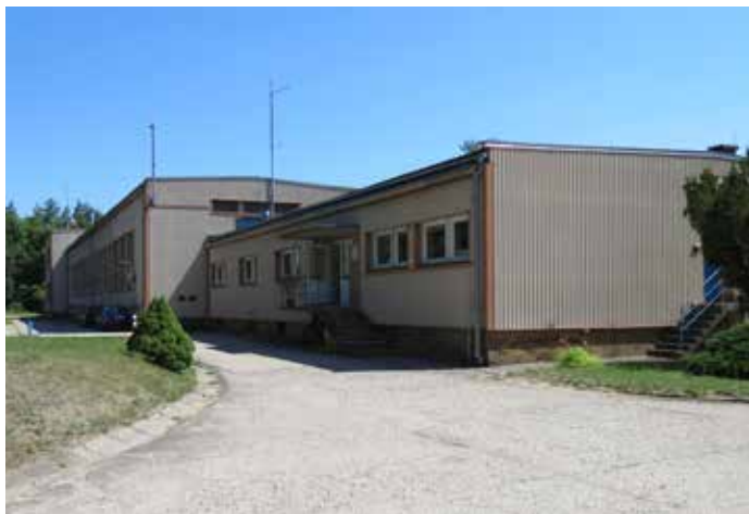
ČERPACÍ STANICE MĚLNICKÁ VRUTICE
