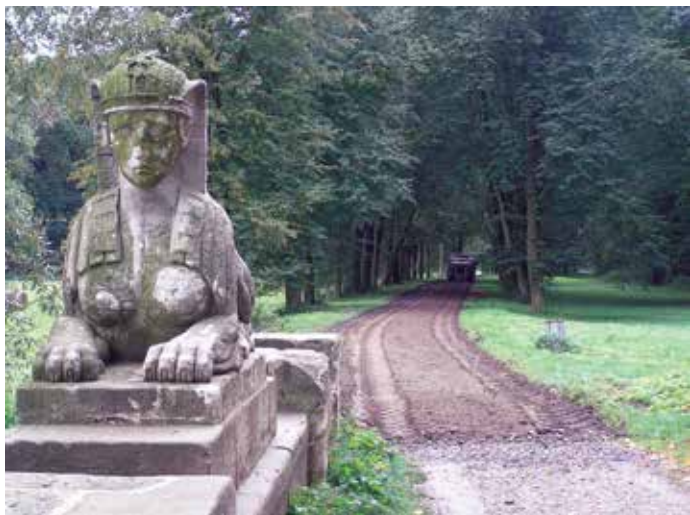
Budování podkladní vrstvy
