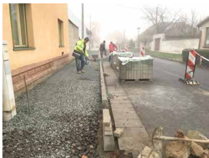
21. listopad 2016 – realizace chodníku v Tyršově ulici, foto bb
