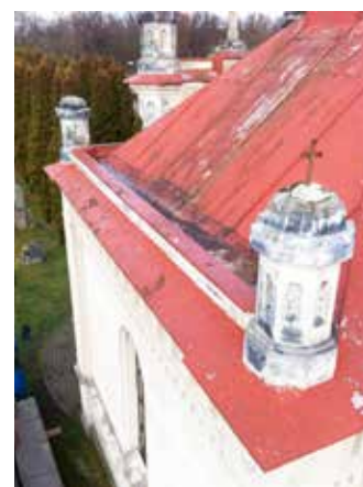
Stav před rekonstrukcí: pohled na střechu kaple
