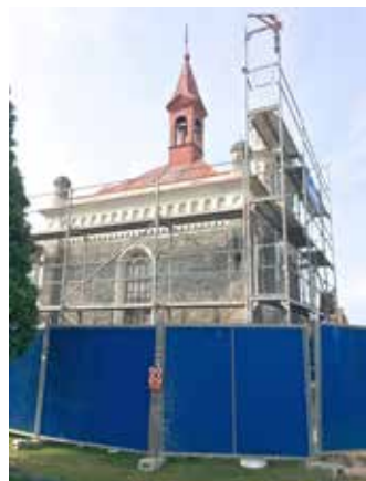
25. září 2016 - oprava hřbitovní kaple foto: Barbora Bělková
