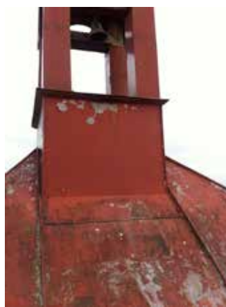
Stav před rekonstrukcí: Detail věžičky
