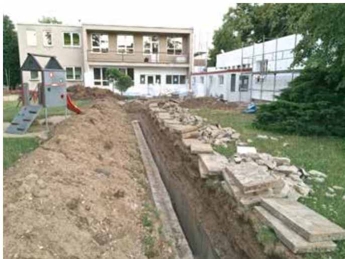
19. červenec 2016 – rekonstrukce teplovodu vedoucího do MŠ, foto Jakub Andrlé
