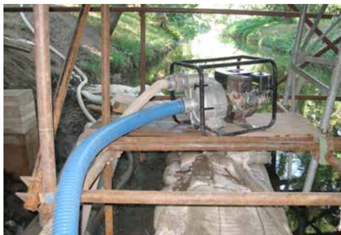
Hráz z pytlů a čerpání vody
