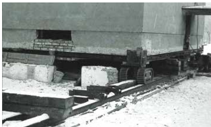
Bylo postaveno přesné kolejiště, po kterém byl dům posouván.
