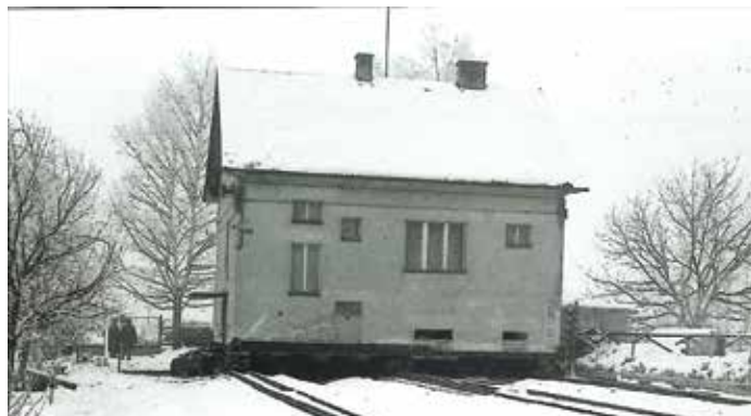
Přemísťování domu č. p. 470
