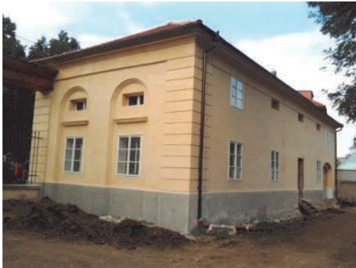
Nová fasáda domu lékaře
