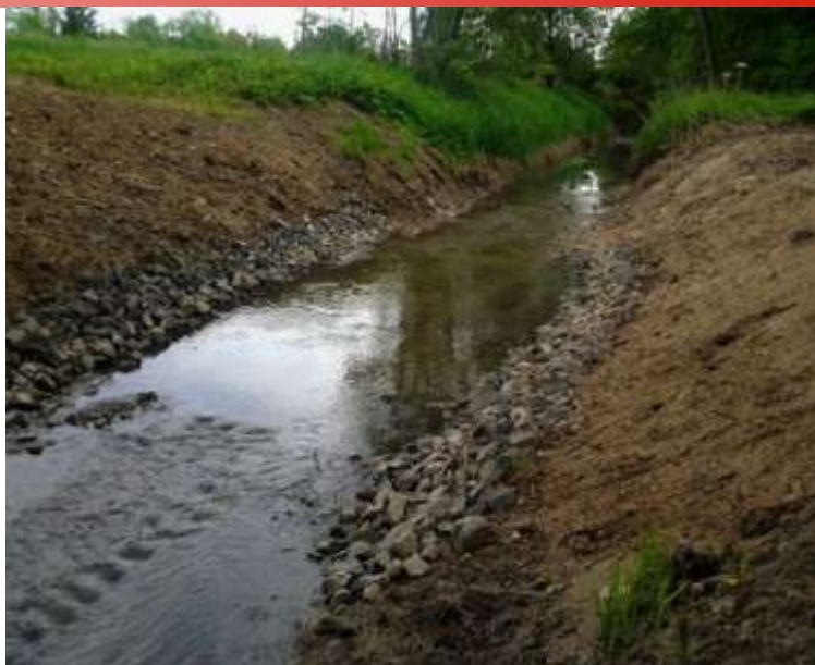
zrekonstruované křížení s produktovody
