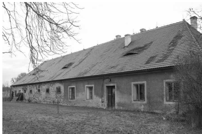
Konírna před rekonstrukcí
