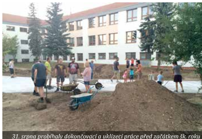
31. srpna probíhaly dokončovací a uklízení práce před začátkem šk. roku
