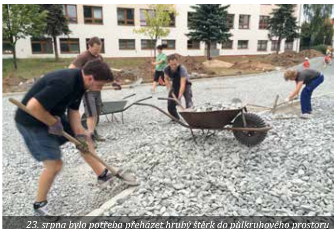
23. srpna bylo potřeba přeházet hrubý štěrky do půlkruhového prostoru
